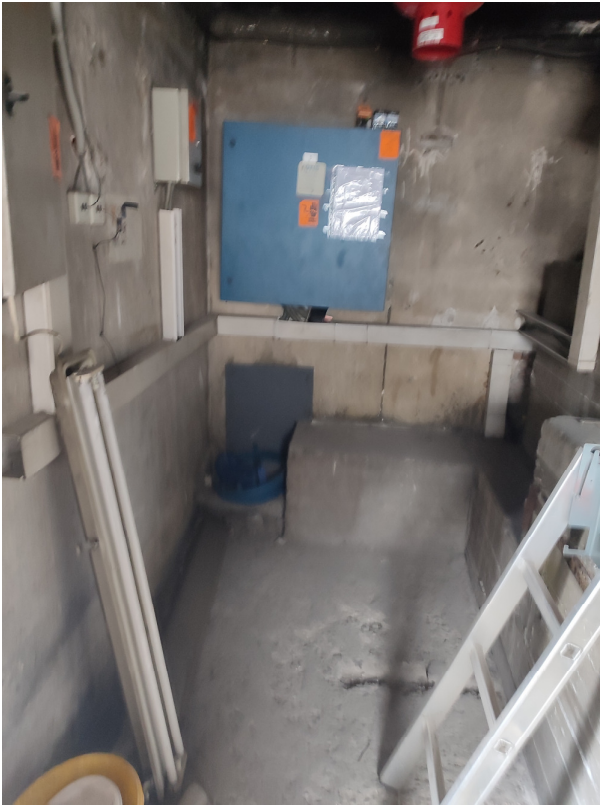
Εικ. 1 Χώρος Μηχανοστασίου 1 , δάπεδο και τοιχοποιίες προς αποκατάσταση με χρώσεις και μονώσεις.
