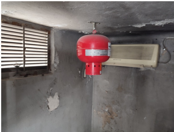
Εικ. 6 Οροφή και εσωτερική τοιχοποιία μηχανοστασίου – απόξεση και χρώση.
