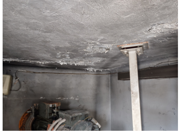
Εικ. 8 Οροφή μηχανοστασίου –απόξεση και χρώση.
