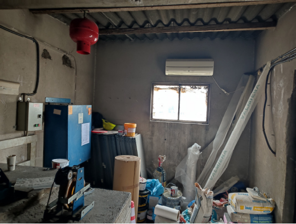
Εικ. 5 Εσωτερικό μηχανοστασίου ανελκυστήρα, χρώσεις, μόνωση δάπεδα και επάλειψη με εποξειδικά υλικά στο φύλλο αμιάντου.
