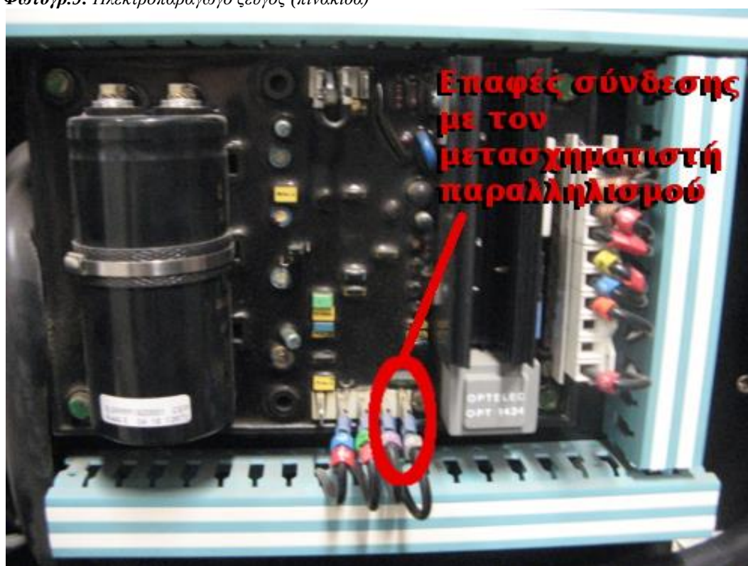
Φωτογρ.10: Ρυθμιστής τάσης H/Z (εντός του ερμαρίου ηλεκτρικών του H/Z)
