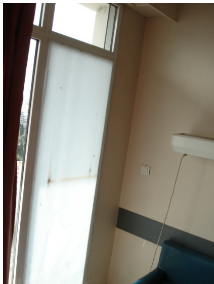
ΕΣΩΤΕΡΙΚΗ ΑΠΟΨΗ - ΘΑΛΑΜΟΣ 1014
