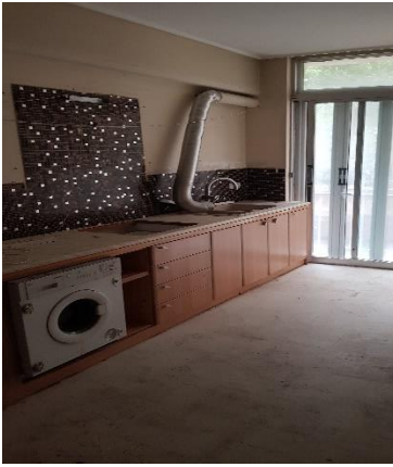
Εικόνα 2- Υφιστάμενη κατάσταση κουζίνας
