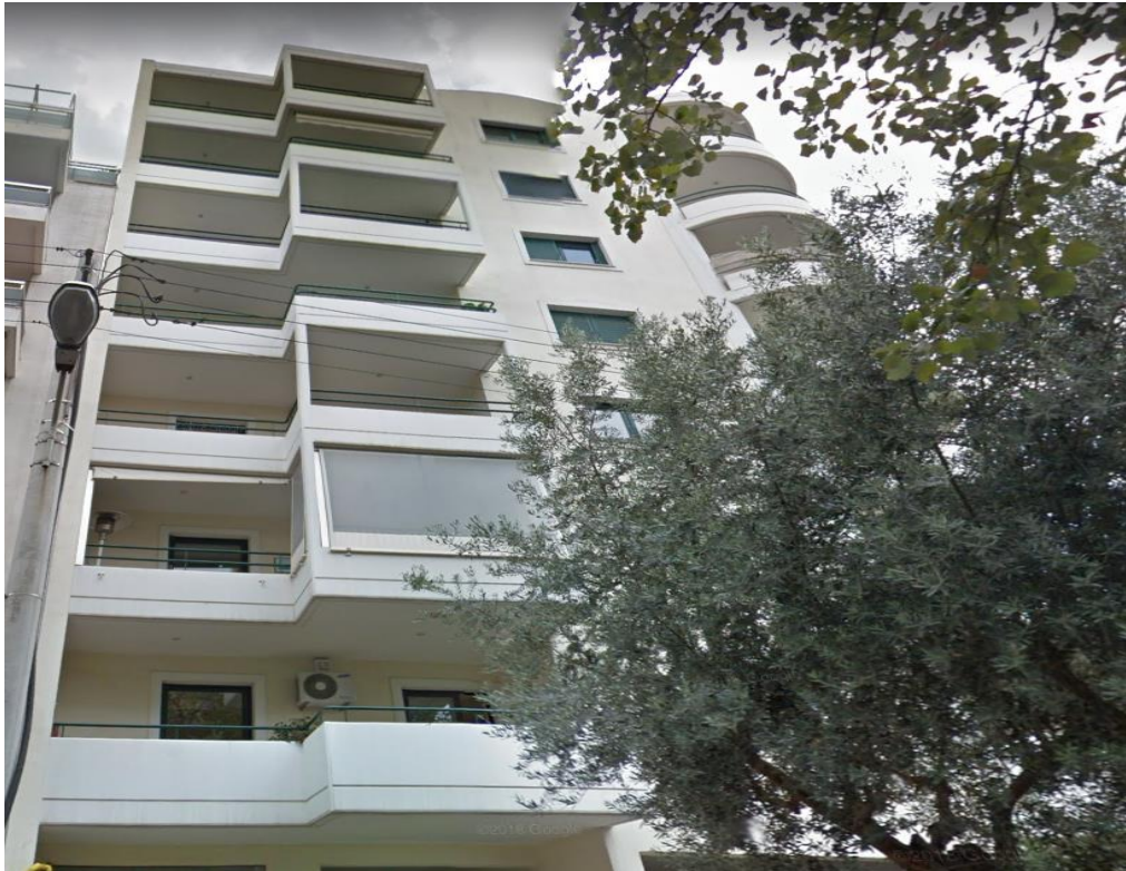
Εικόνα 1- Εξωτερική άποψη του κτιρίου
