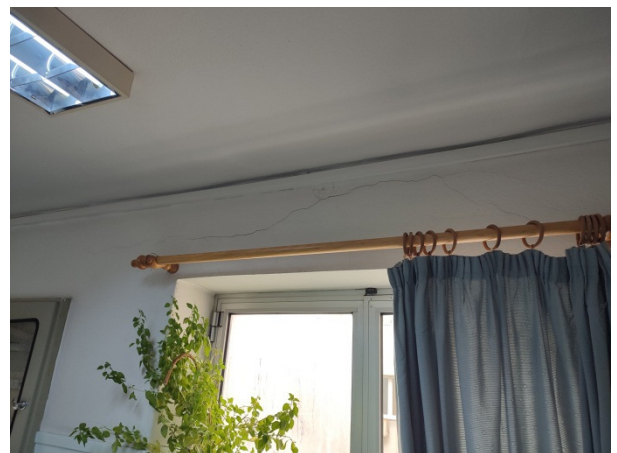
Εικ. 5 Έλεγχος ρωγμών και αποκαταστάσεις με χρώσεις
